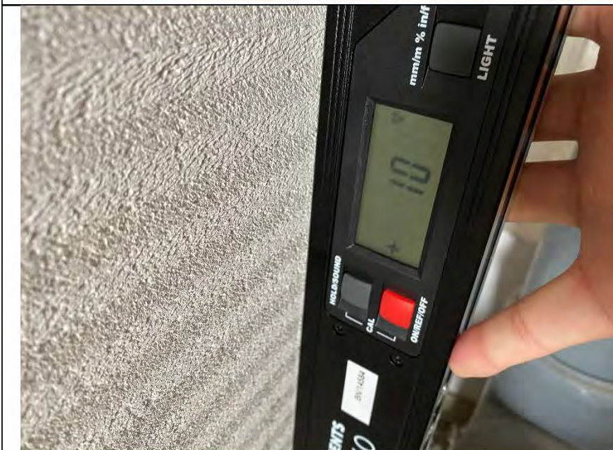
Фото №50. Измерение уровня кладки в ванной комнате.
