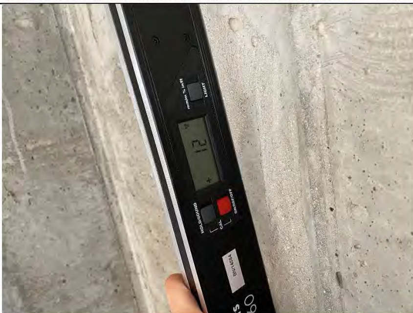
Фото №41. Измерение уровня ж/б стены в санузле.
