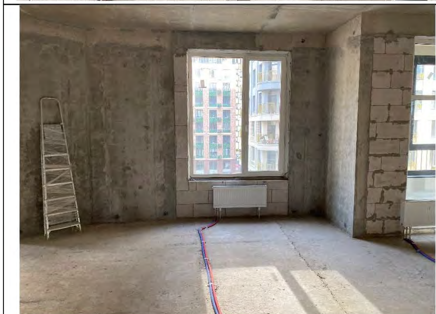
Фото №2. Общий вид квартиры.
