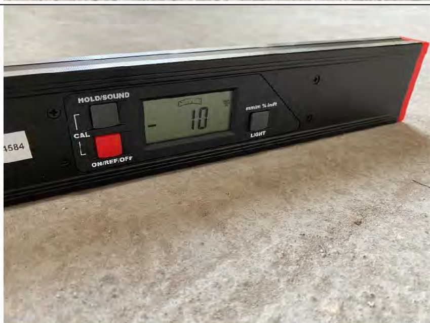
Фото №48. Измерение уровня горизонтальных ж/б элементов в коридоре.
